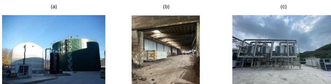
Figura 17: Stabilimento IREN, Cairo Montenotte, SV. Nella figura a) è possibile vedere il bioreattore e il serbatoio del biogas prodotto. Nella figura b) le biocelle per la stabilizzazione del compost e la figura c) rappresenta l'impianto di purificazione del biogas.
